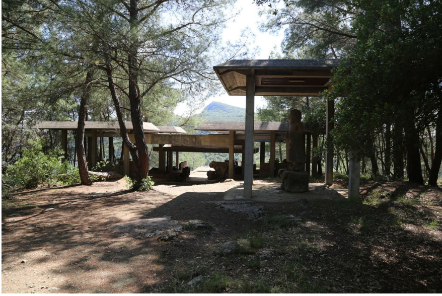
Güney Kapı, Genel Görünüm: Eserler ve Turgut Cansever Saçakları - Karatepe
