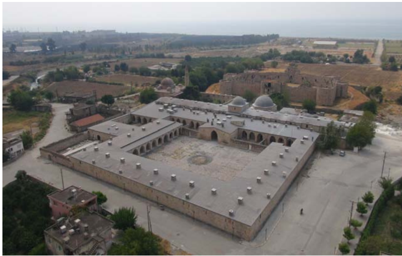
Payas Külliyesi – Restorasyon sonrası 2013 sonu
